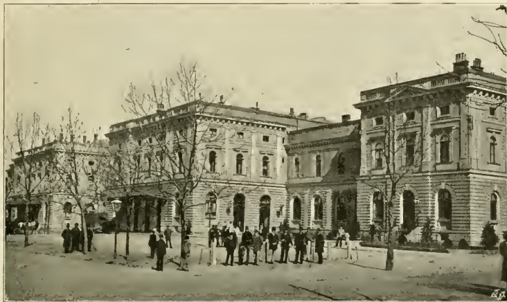
Abb. 277. Umgestaltetes Aufnahmegebäude Krakau der Nordbahn [1895.]
